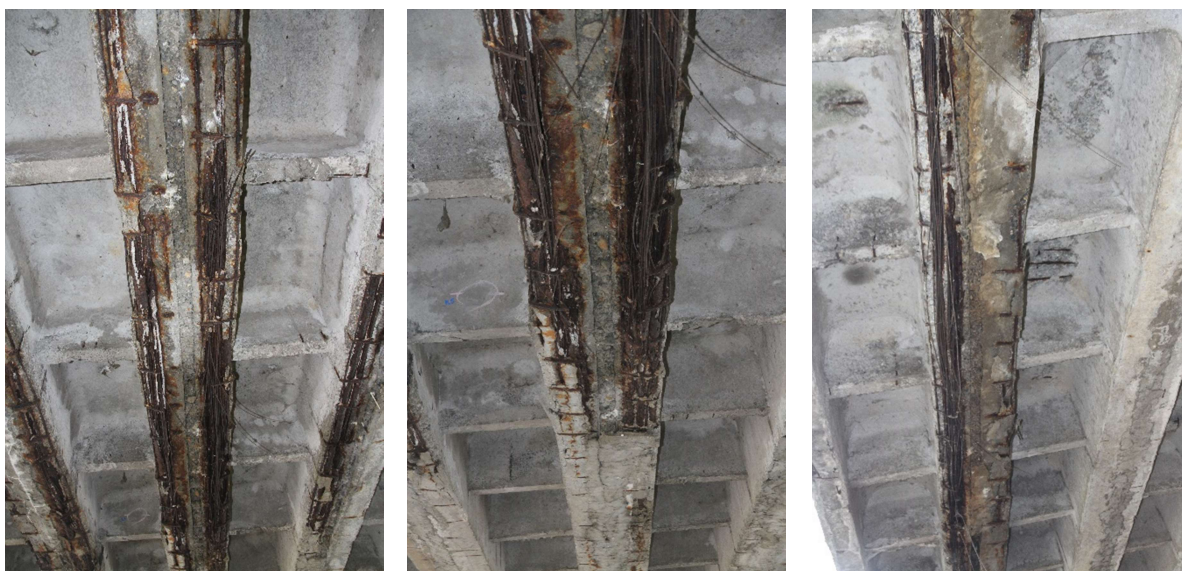
Obr. 25 Poškodená, pretrhnutá a skorodovaná pozdĺžna predpínacia výstuž v nosníku N6 a N7 (vľavo, v strede), v nosníku N1 a N2 (vpravo)
