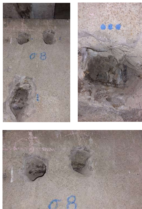
Obr. 20 Odkrytá výstuž, opora O1
