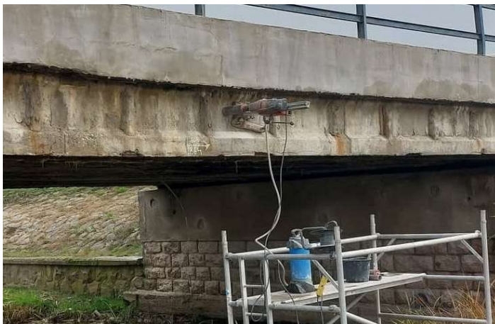
Obr. 7 Realizácia vývrtov vŕtačkou HILTI DD 160
