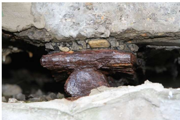
Obr. 30 IMG(27) Ložiská
