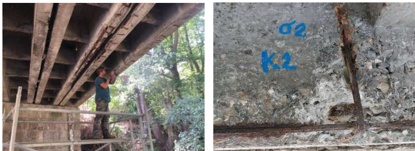
Obr. 13 Deštruktívne odkrytie výstuže
