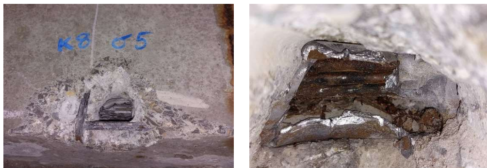
Obr. 14 Odkrytie predpínacieho kanálika
