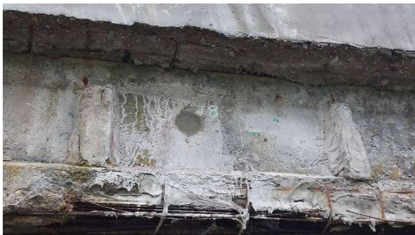
Obr. 8 Vyspravenie vývrtov sanačnou zmesou
